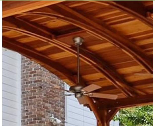
Ceiling Fan Base
