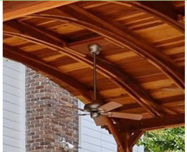
Ceiling Fan Base
