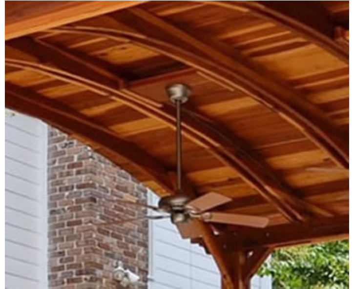
Ceiling Fan Base
