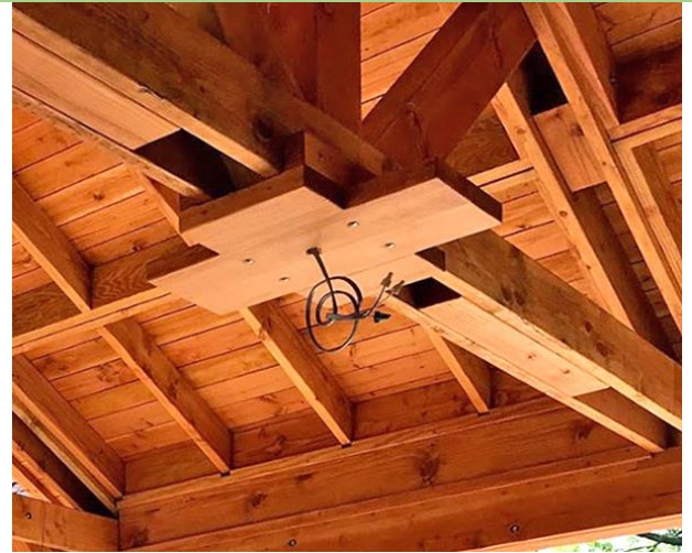
Ceiling Fan Base
