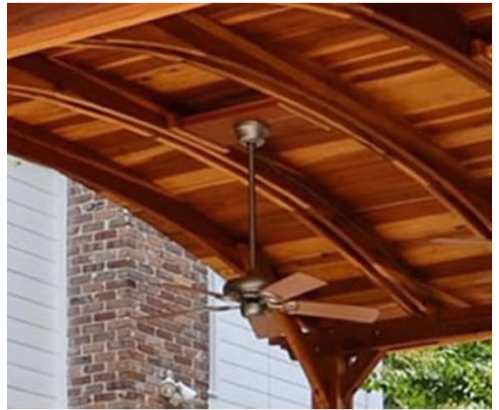
Ceiling Fan Base
