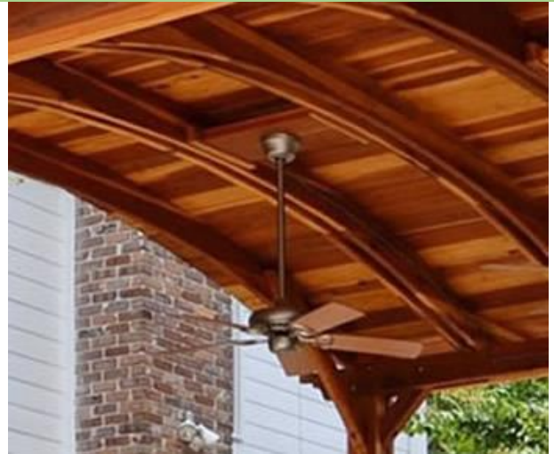
Ceiling Fan Base
