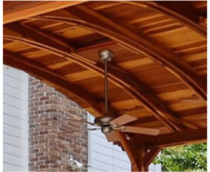
Ceiling Fan Base
